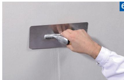
6 Nahtbereich andrücken und anschließend auch hier die Zahnung verpressen, bis die Spachtelmasse ganz leicht das Vlies durchdringt. Wiederholen Sie den Vorgang bis zur vollflächigen Fertigstellung.
