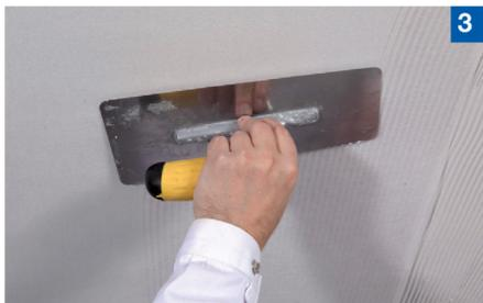
3 Die Zahnkellenstruktur unterhalb des Vlieses mit einer Glätte-Kelle verpressen, bis die Spachtelmasse leicht das Vlies durchdringt. Dabei bis ca. 5 mm an den Nahtbereich arbeiten.
