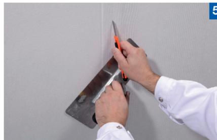
5 Doppelnahtschnitt mit dem Cuttermesser setzen und abgetrennte Vliesstreifen entfernen.
